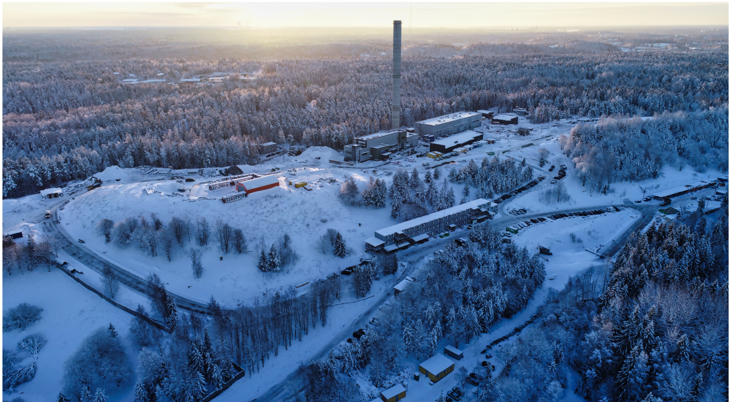
Kuva 11.1 Blominmäen jätevedenpuhdistamo tammikuussa 2021. Kuva: Martti Keskinen, YIT.
