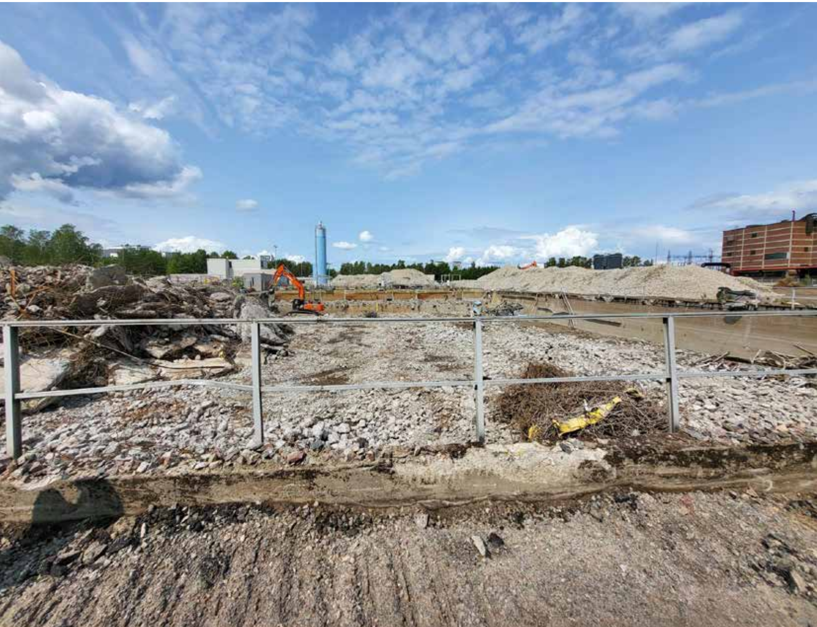
Kuva 12.1 Suomenojan jätevedenpuhdistamon purkutyömaata kesällä 2025.
